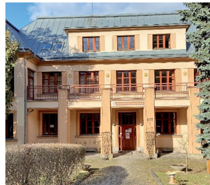
BD Hajnice – soc. rehabilitace, Oranžová kavárna, Trutnov
